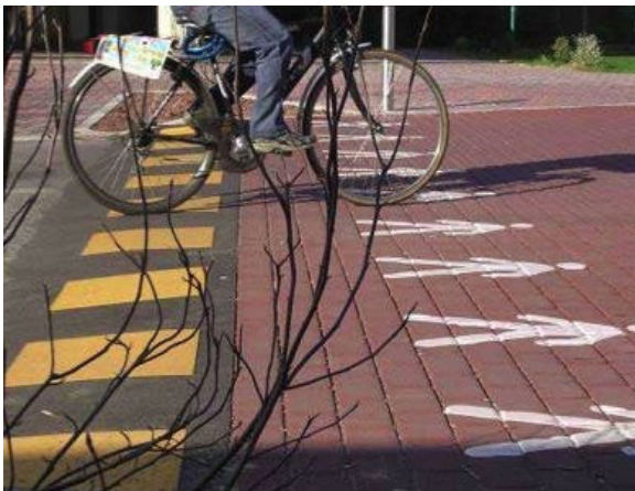
Fig. 1 – Rampe a moderata pendenza, utilizzo di materiali differenziati, presegnalazioni sono possibili anche per risolvere le situazioni di promiscuità tra categorie veicolari sulle strade principali
