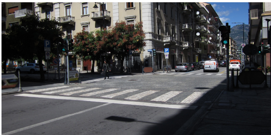
Fig. 2 b – Esempio di realizzazioni di provvedimenti di mitigazione della velocità facendo ricorso a piattaforme rialzate e materiali differenziati su strade urbane principali
