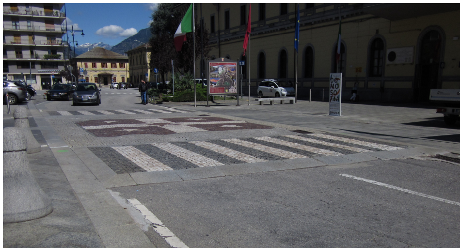
Fig. 2 a – Esempio di realizzazioni di provvedimenti di mitigazione della velocità facendo ricorso a piattaforme rialzate e materiali differenziati su strade urbane principali
